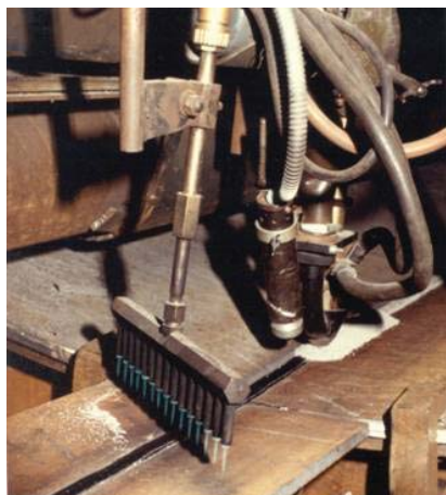
Рис 3. Локальный нагрев газовыми горелками совмещенный с процессом сварки
