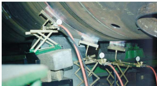
Рис 9. LINDOFLAMM® подогрев корпуса свариваемого химического резервуара
